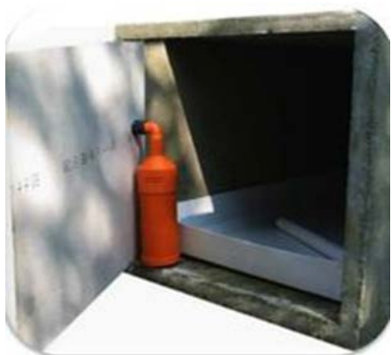
Immagine n°7: Esempio di trasformazione di loculo esistente tradizionale nel tipo "aerato". Sono visibili il filtro depuratore (rosso) collegato alla lastra di sigillo e la vaschetta raccolta liquidi (bianca) inserita nel vano preesistente.
