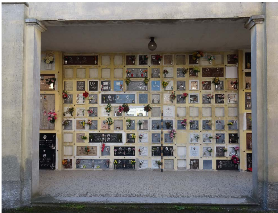
Immagine n°6: esempio di ossari e di cinerari privati in concessione
