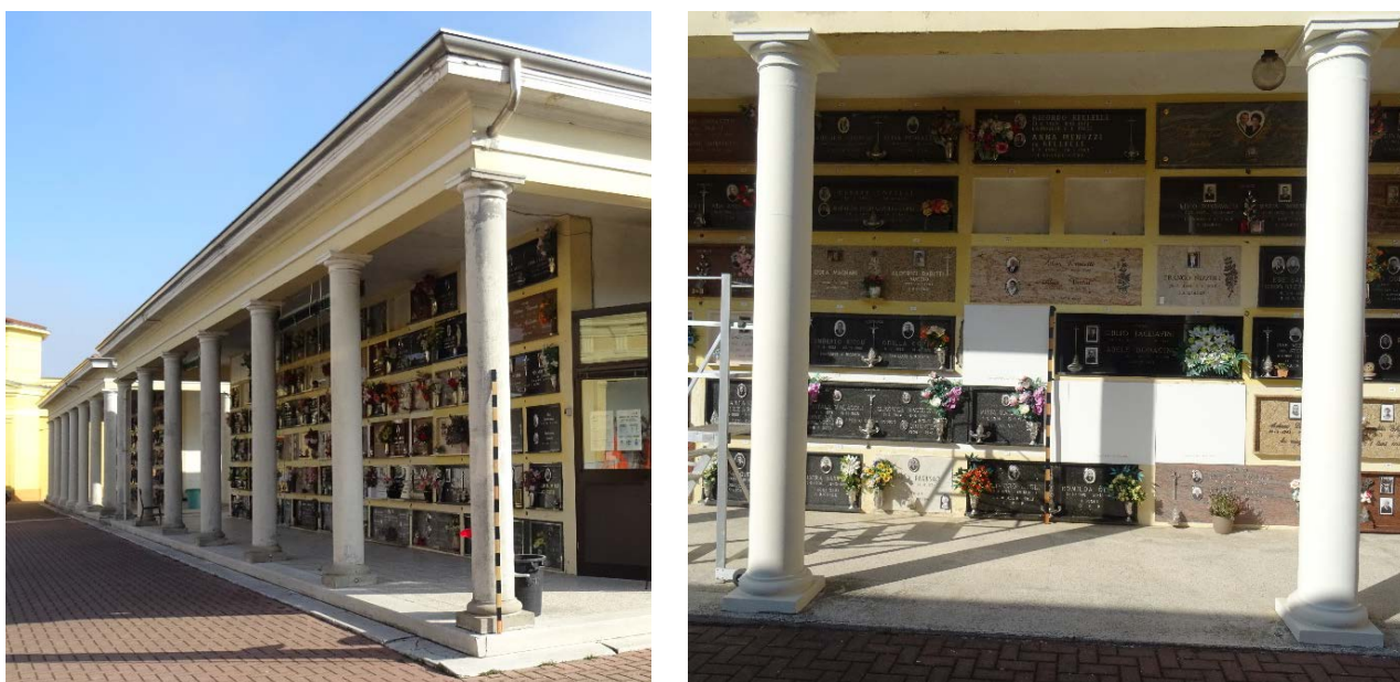
Immagine n°3: esempio di loculi in galleria porticata
