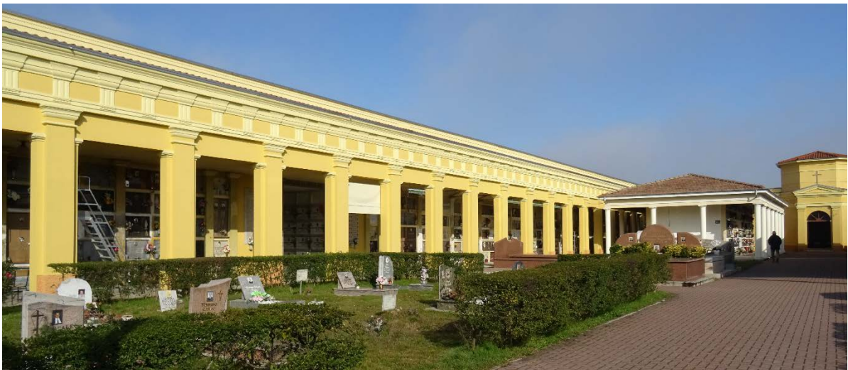
3. Ceppo storico del plesso: zona antistante l'ingresso principale: sono visibili un campo di inumazione, galleria di loculi perimetrale.
